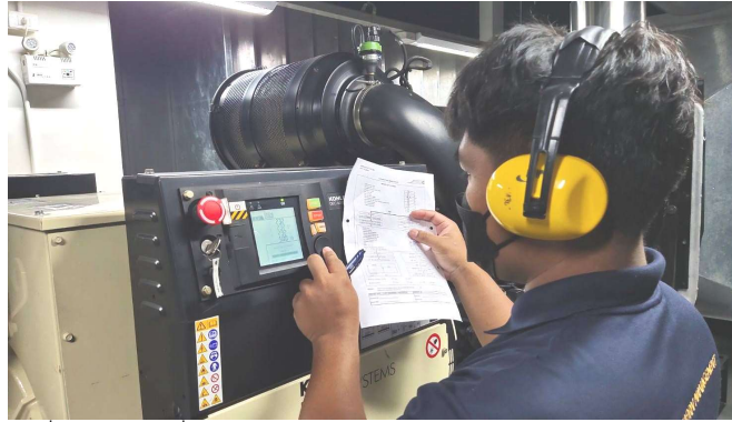
ภาพที่ 3-15 ห้องเครื่องระบบไฟฟ้าฉุกเฉิน และการตรวจสอบระบบไฟฟ้าฉุกเฉิน
