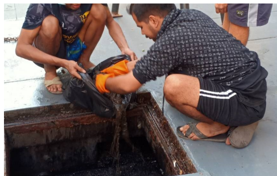
ภาพที่ 3-40 ขุดลอกท่อระบายน้ำและบ่อหน่วงน้ำ
