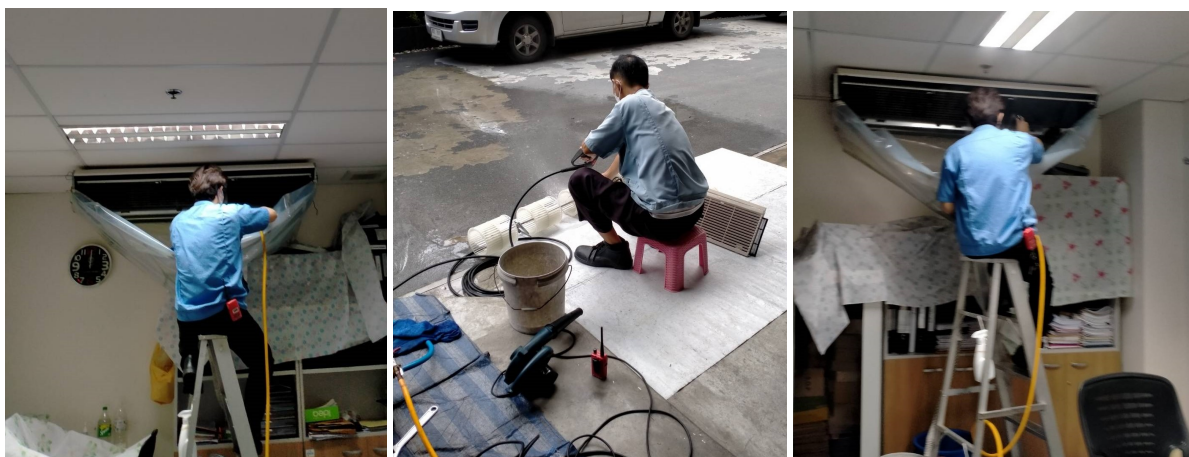
ภาพที่ 3-42 ล้างเครื่องปรับอากาศภายในอาคาร
